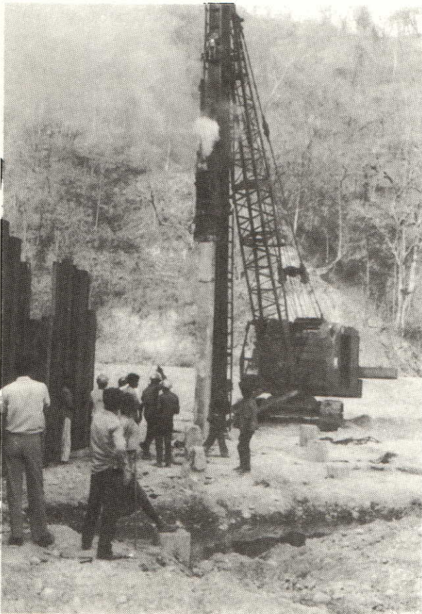
Weir Body Piling Apr. '75
